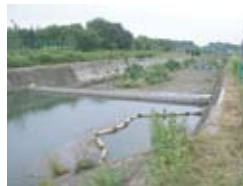
礫間浄化施設（大堀川）
